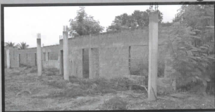
Cmeido Santo Amaro começou a ser construído em 2017
